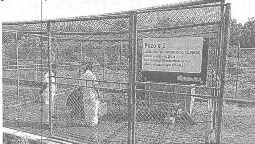
Fotografía No. 2 pozo #2 con estructura de cerramiento (Caseta de Protección)
